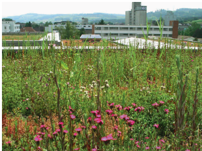
Toitures plates végétalisées quasi naturelles (intensives/extensives)
