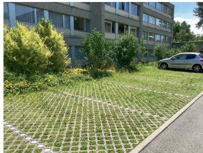
Surfaces de circulation avec revêtements infiltrables, graviers engazonnés carrossables
