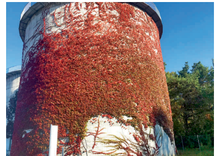
Végétalisation de façades
