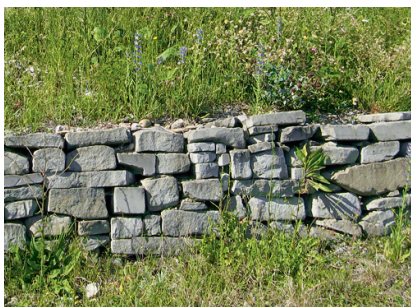
Murs de pierres sèches
