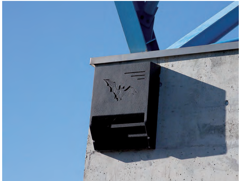
S'il est plus élégant de l'intégrer dans la structure ou la façade d'un bâtiment, l'ajout ultérieur d'un nichoir (ici à chauves-souris) reste possible.
