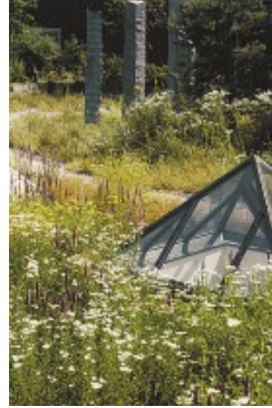
Blumenpracht auf dem Flachdach der Swisscom in Ostermundigen. Une végétation luxuriante sur le toit plat de Swisscom à Ostermundigen.
