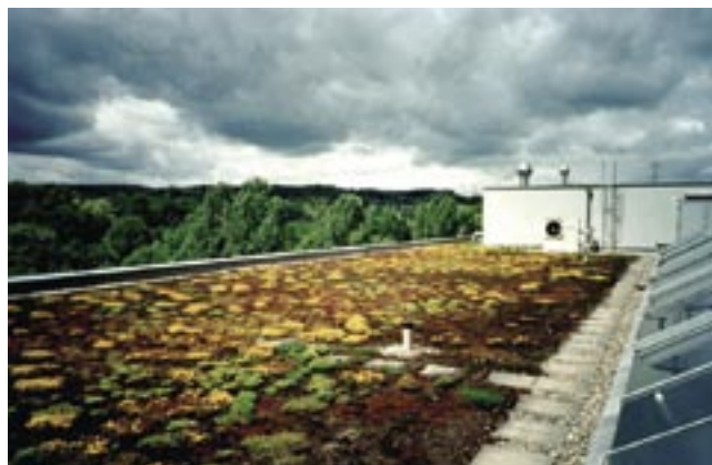
Wolkenstimmung über einem begrünten Flachdach der EBM in Münchenstein.
