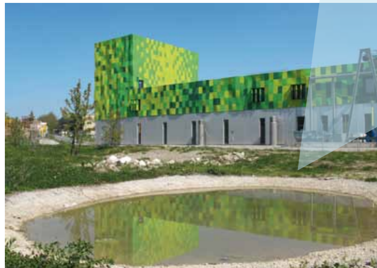
La STEP du Bois-de-Bay: un écrin de zones humides et de plantes indigènes pour une architecture hors du commun.
